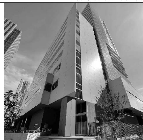
「みなとみらいキャンパス」外観。 左奥に見える横浜ランドマークタワーからも近い
